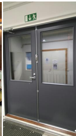
Hiihtomajalle asennettiin sähköiset ovet
